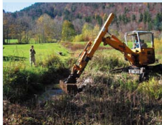
Octobre 2005, l'APSSA organise la revitalisation de l'étang par des travaux de curage importants; M. Ducommun avec sa pelle-rétro.
