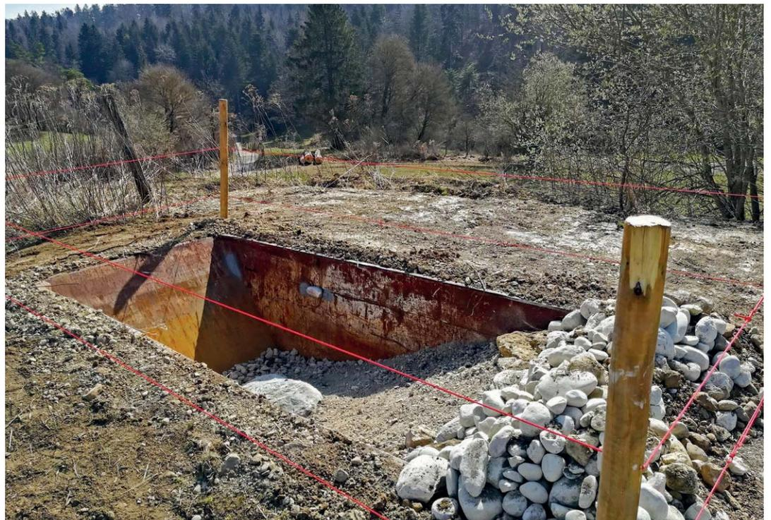
*Après quelques soudures pour les rendre étanches, les bennes sont partiellement remplies de graviers et de galets.*
