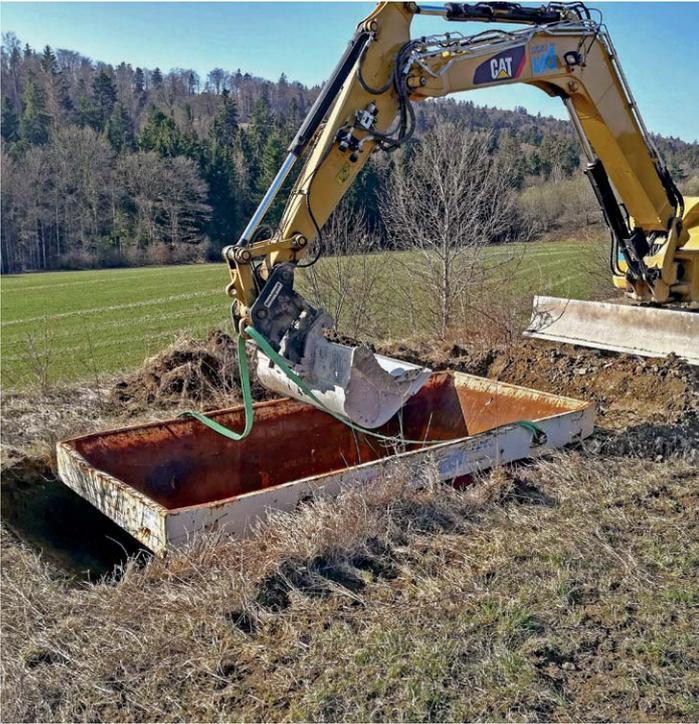
*Pose d'une des bennes dans sa fosse. La terre excavée est réutilisée sur place pour mettre le bord de la benne à fleur de terrain.*
